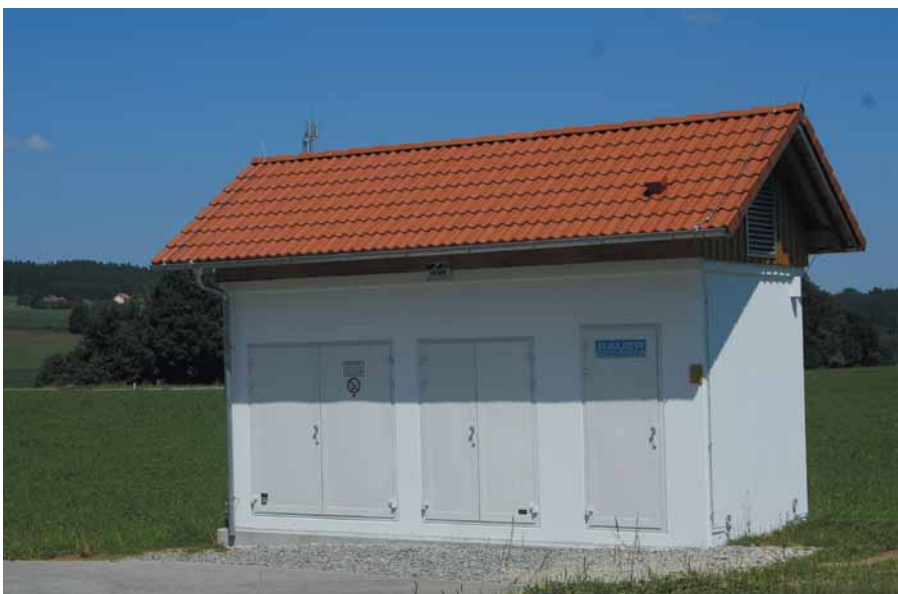
Das Kompressorenhaus passt sich in die Umgebung ein.
